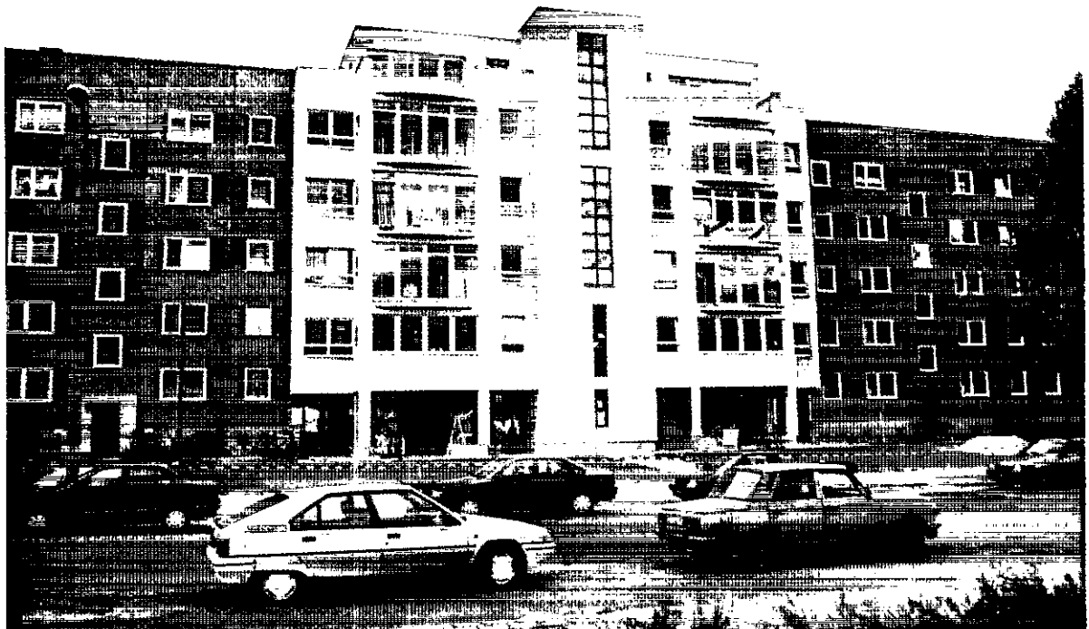
Wohn- und Geschäftshaus als Lückenschließung
