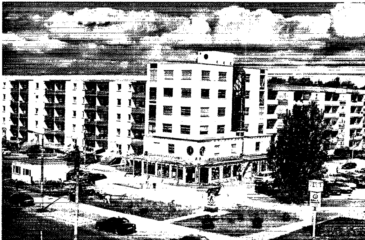
Stand nach Fertigstellung August 1993
