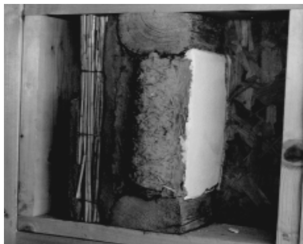
Abb. 1: Außenwandaufbau mit Edelputz, Lehm-Hack-schnitzel-Ausfachung, Holzleichtbauplatte, Schilfrohrmatte
