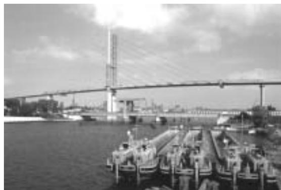
Mit dem Einhub der letzten beiden Überbauteile wurde am 6. April 2006, gerade 18 Monate nach Baubeginn, die Montage der technisch anspruchsvollen Schrägseilbrücke über den Ziegelgraben erfolgreich abgeschlossen. Die Rügenbrücke im Zuge der 2. Strelasundquerung ist die derzeit größte und längste Brückenbaustelle Deutschlands und soll 2007 fertig gestellt werden.
