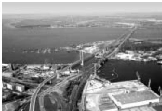
Besonderes Augenmerk wurde dabei dem „Führungstragwerk“, der 42 m hohen und 198 m weiten Überspannung des Ziegelgrabens gewidmet. Die inzwischen realisierte Schrägseilbrücke besticht durch ihre Eleganz und Schlankheit, ihre harmonische Einbindung in das maritim geprägte Umfeld sowie durch die gestalterisch, technisch und wirtschaftlich vorteilhafte Tropfenform für alle druckbeanspruchten Traglieder.
