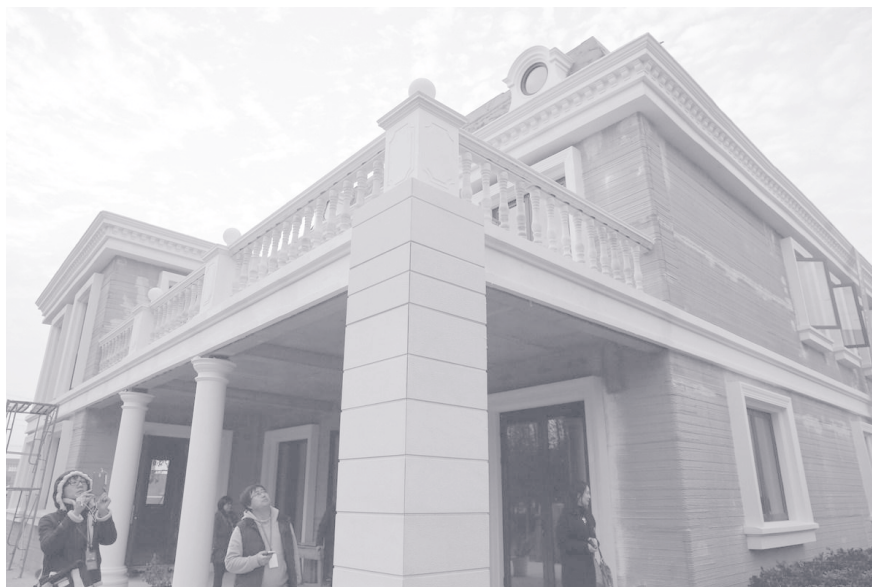
Villa in Shanghai mit additiv gefertigten Wandelementen
