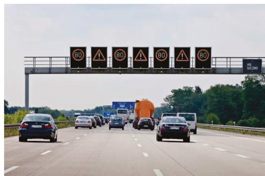
Abbildung 11 Streckenbeeinflussungsanlage,
