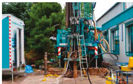
Dieses Bild zeigt eine Erdwärmesondenbohrung mit integrierter Messtechnik auf dem Firmengelände der Burkhardt GmbH.
