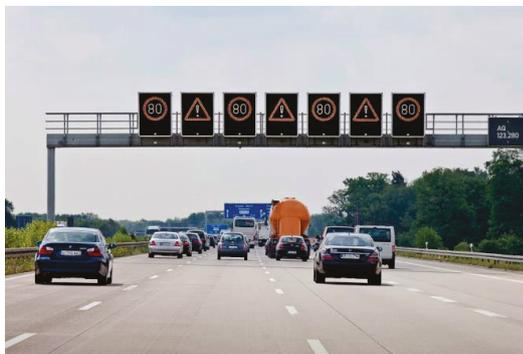
**Abbildung 10 Streckenbeeinflussungsanlage (SBA),
