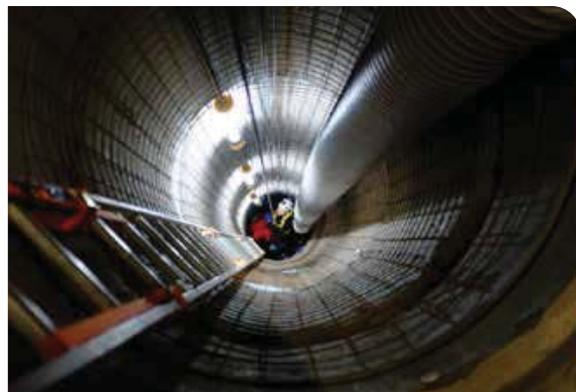
Installation der Instrumentierung in Sandwich-HP-Experimentalschacht
