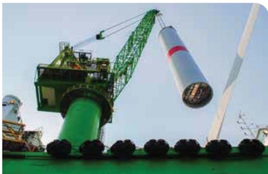
Der Rückbau von Windenergieanlagen auf See ist aufwändig und kostenintensiv.
