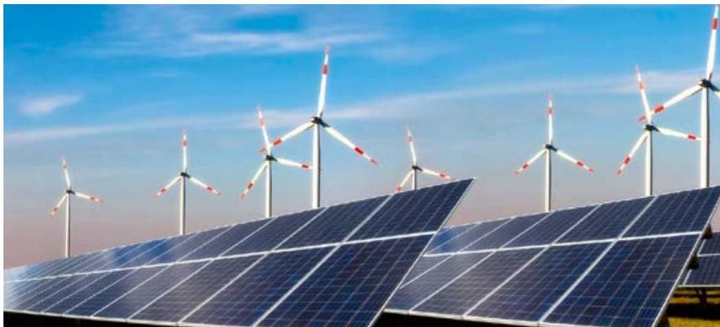
Photovoltaik- und Windkraftanlage in Deutschland
