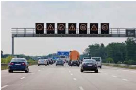
**Abbildung 10 Streckenbeeinflussungsanlage (SBA),**
