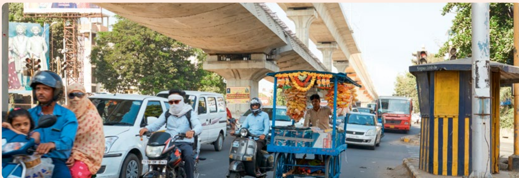
Bau der Hochbahn in Nagpur, Indien
