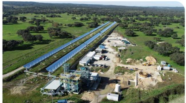
Luftaufnahme der HPS2-Forschungsanlage: Parabolrinnenspiegel (links oben), bedachter Drainage-Speicher (links unten), Stahlbau mit Speichertanks und Dampferzeugersystem (unten), Büro und Leitwarte-Container (Mitte).
