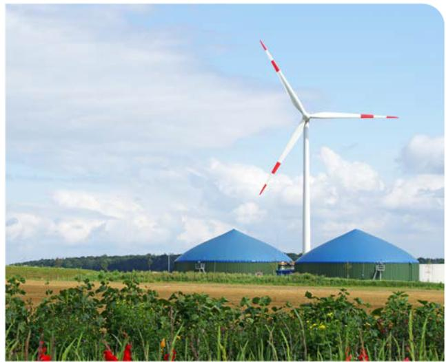
Im Projekt WeMetBio wird die Integration einer innovativen Pilotanlage zur Biomethanisierung im Rieselbettverfahren in den Energieverbund von Biogas- bzw. Biomethananlagen, Windkraftanlagen sowie die Methaneinspeisung ins Erdgasnetz geprüft.
