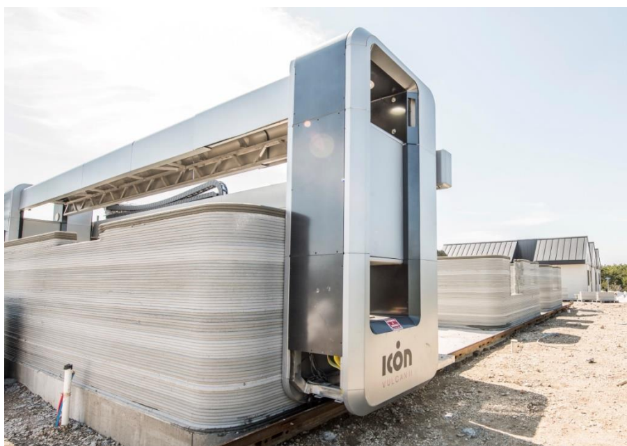
Abb. 4.3 3-D-Maschine: Manipulator und Druckkopf
