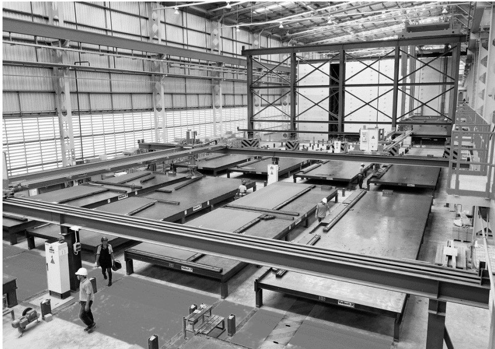
Abb. 5.3 Herstellung von Betonfertigteilen mit einer automatisierten Palettenumlaufanlage
