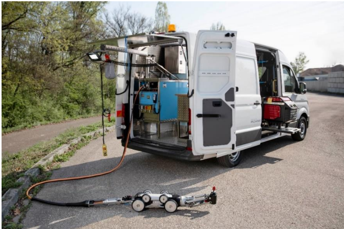
Abb. 4.10 Einsatzwagen und Ausstattung für Robotereinsatz im Kanalnetz
