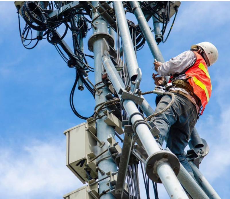
Arbeiten an einem Funkmast
