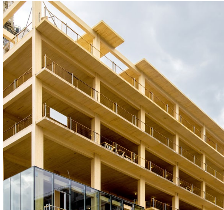
Mehrgeschossiges Gebäude in Holzskelettbauweise
