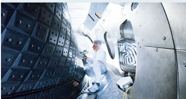
Montage der Grafitkacheln im Plasmagefäß von Wendelstein 7-X
