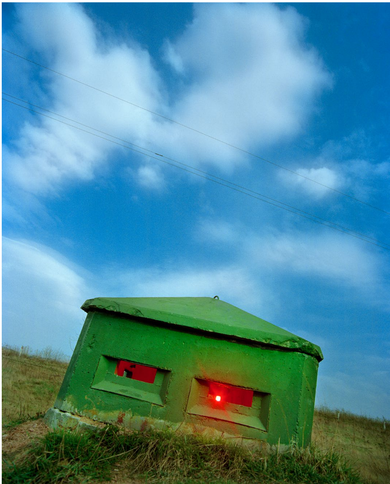
Beobachtungsbunker, Grenzabschnitt Wartha bei Eisenach (TH), 1990
