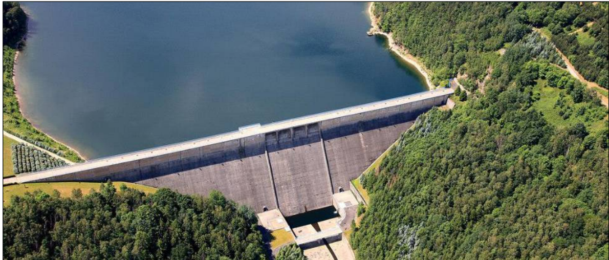
Abbildung 5: Luftaufnahme der Talsperre Gottleuba (Quelle: Landestalsperrenverwaltung Sachsen)
