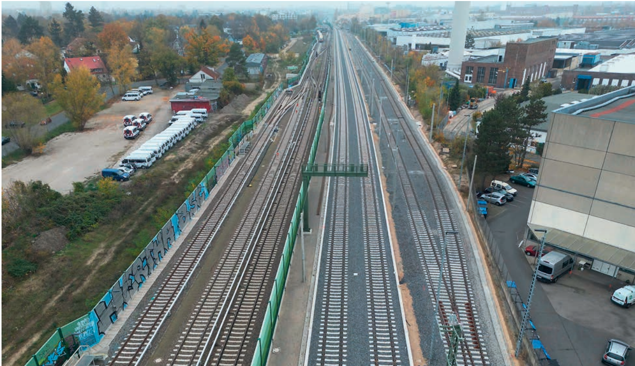
Abbildung 5 Neue Infrastruktur im Abschnitt Marienfelde (Projekt Dresdner Bahn) Foto: DB E&C
