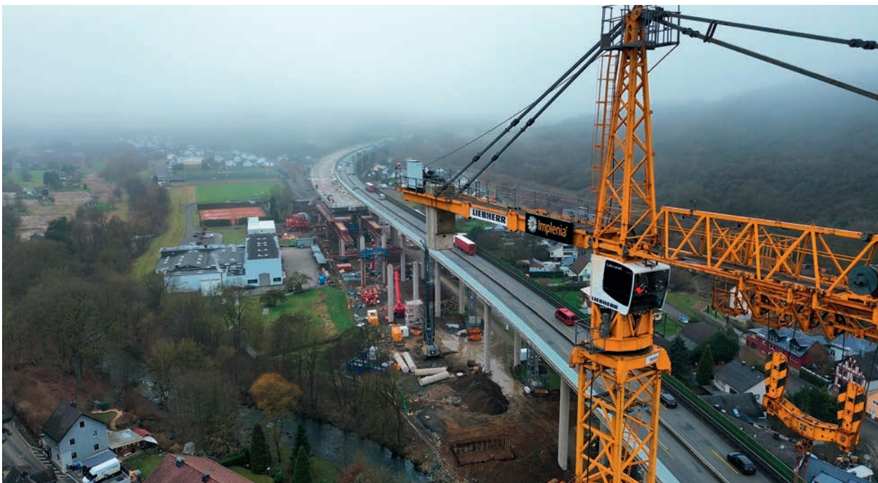
Abbildung 35 Überblick über die Baustelle der Talbrücke Sechshelden auf der A 45, Blickrichtung Dortmund Foto: Die Autobahn GmbH des Bundes, Niederlassung Westfalen
