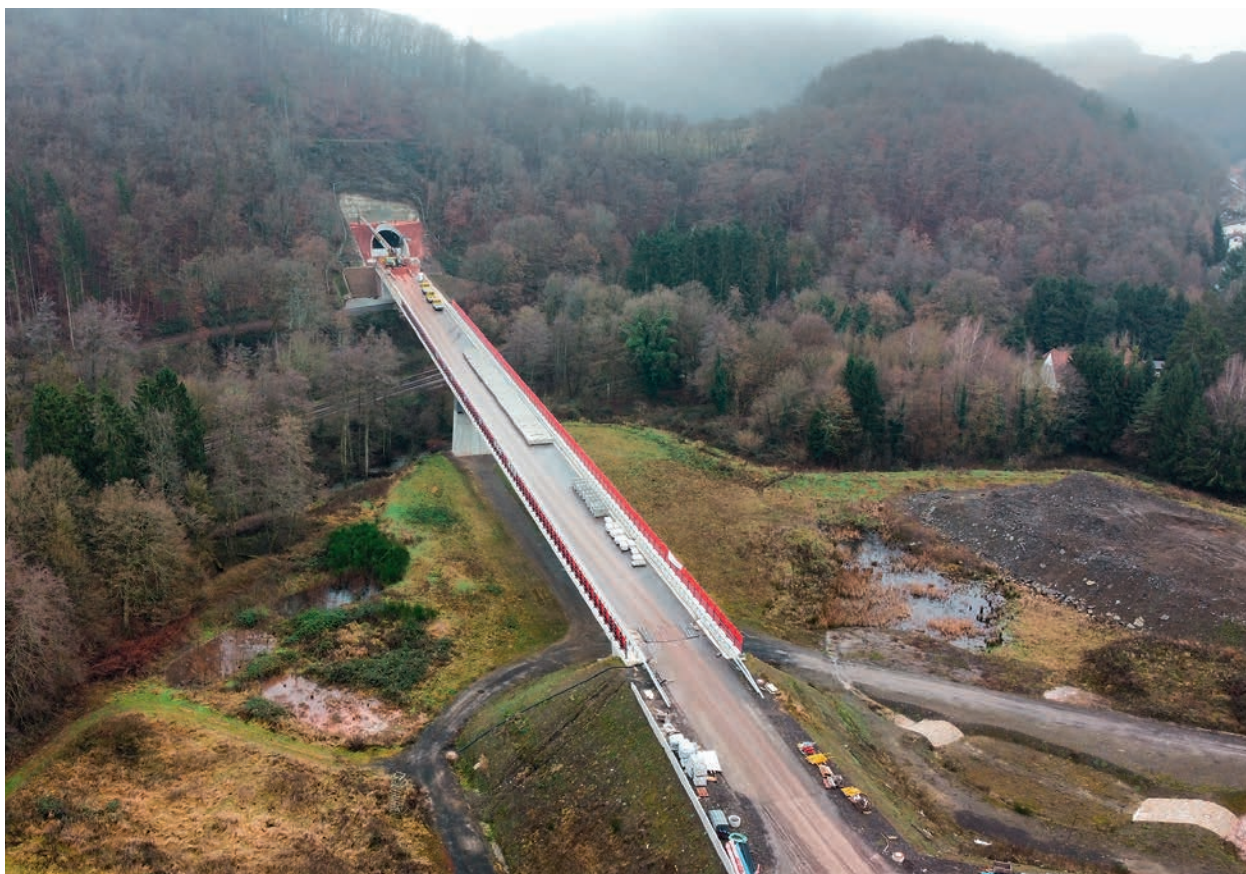
Abbildung 43 B 48 neu, Ortsumfahrung Imsweiler Foto: Landesbetrieb Mobilität Speyer
