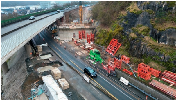
Abbildung 33 Unterführung der Bundesstraße B 277 unter der Talbrücke Sechshelden auf der A 45 Foto: Die Autobahn GmbH des Bundes, Niederlassung Westfalen
