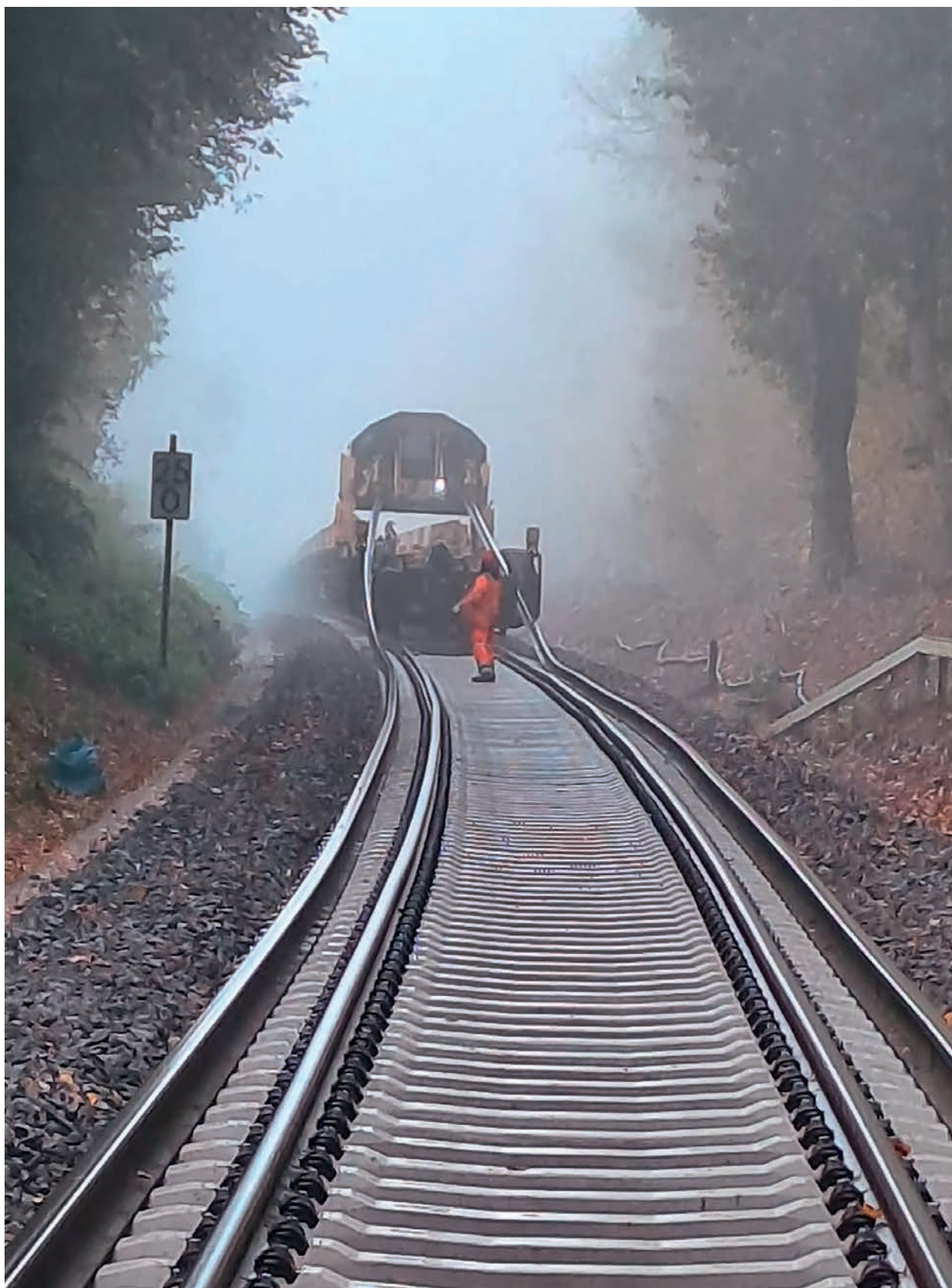
Abbildung 12 Schienenverlegung Foto: N. Spindelmann
