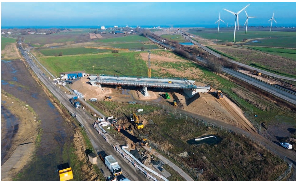
Abbildung 45 B 207, vierstreifiger Ausbau zwischen Heiligenhafen-Ost und Puttgarden Foto: DEGES
