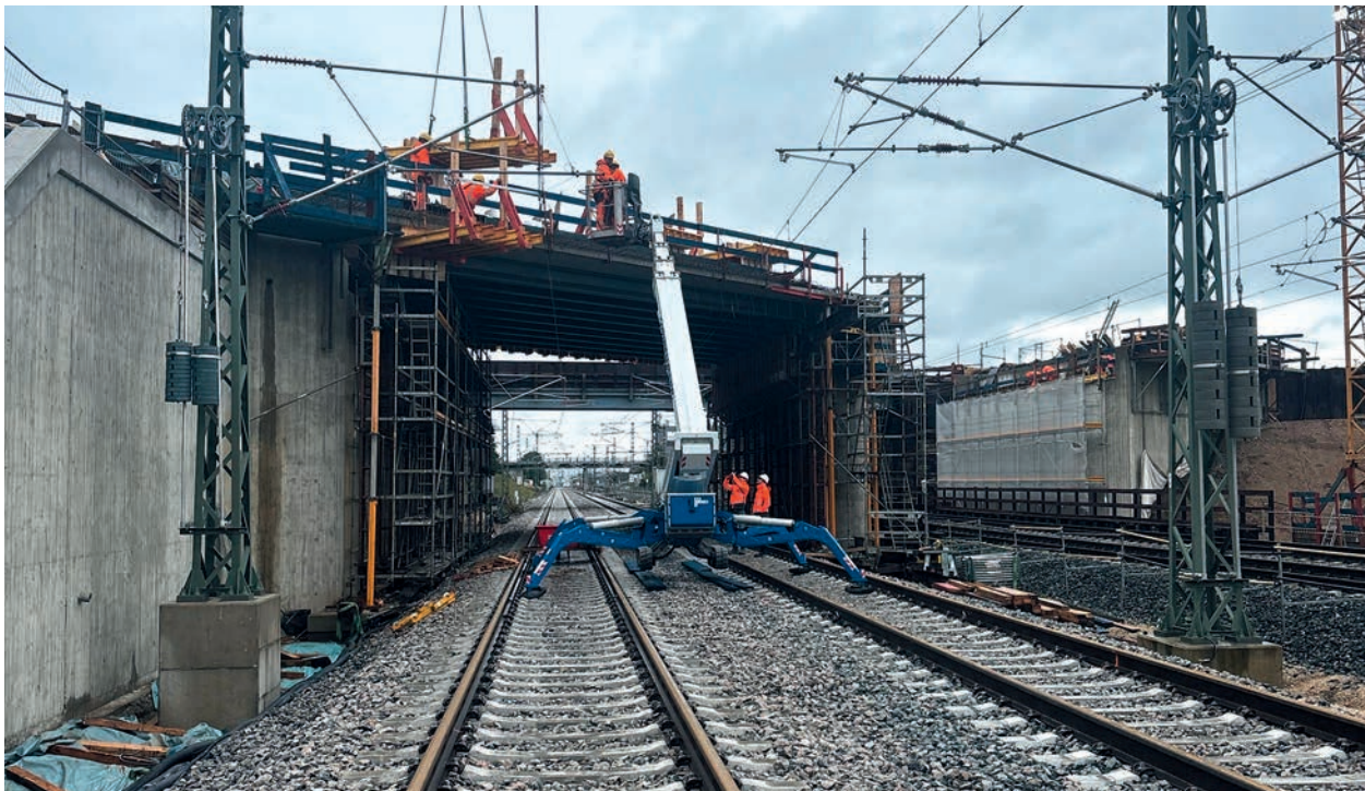
Abbildung 2 B505 – Rückbau Konsolen und Traggerüst Foto: Rebecca Zinkl
