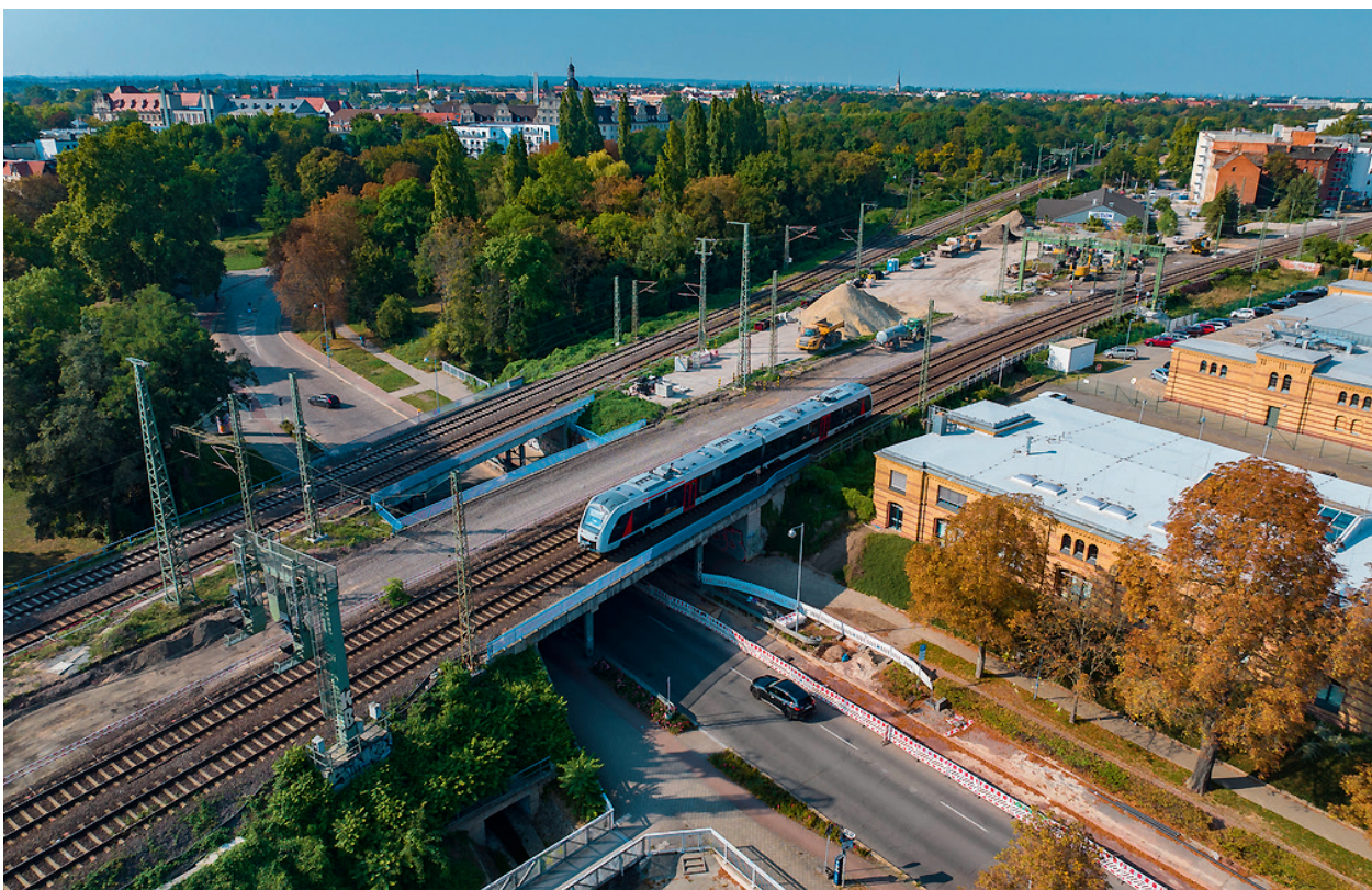
Abbildung 8 Sichtbrücke Carl-Miller-Straße – Arbeiten an einer Signalbrücke Foto: DB InfraGO
