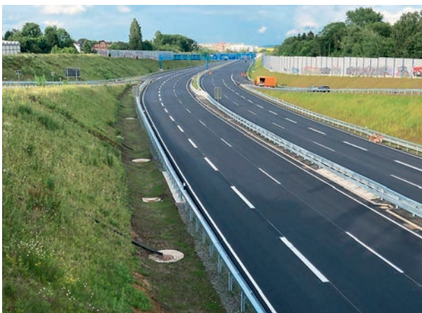
Abbildung 26 Blick auf die fertige Fahrbahn-Trasse der A 448 bei Bochum Foto: Die Autobahn GmbH des Bundes, Niederlassung Westfalen
