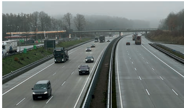
Abbildung 21 Blick auf die fertige Trasse der A 1 Foto: Die Autobahn GmbH des Bundes, Niederlassung Westfalen
