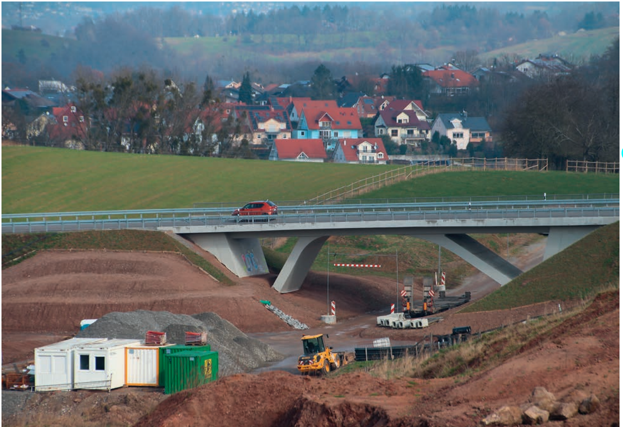
Abbildung 39 B 38, Ortsumgehung Mörlenbach, Panoramastraße Foto: Hessen Mobil
