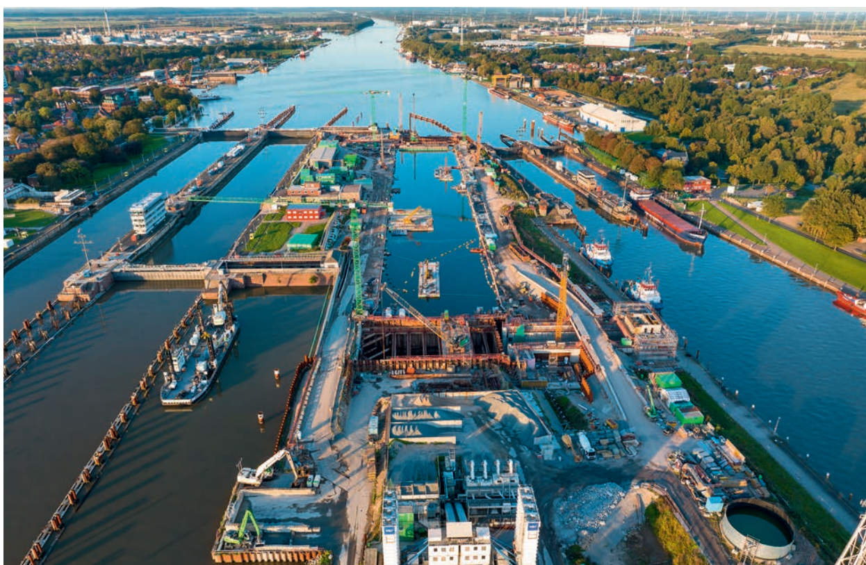
Abbildung 53 Bau der 5. Schleusenammer Brunsbüttel/Nord-Ostsee-Kanal Foto: WSV
