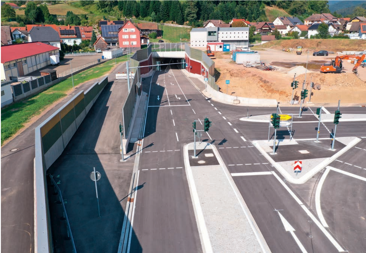
Abbildung 36 B 294, Ortsumgehung Oberwinden – Brandbergtunnel, Südportal des Brandbergtunnels, Foto: Regierungspräsidium Freiburg
