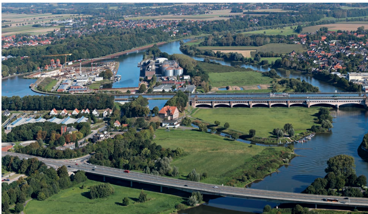
Abbildung 54 Minden Wasserstraßenkreuz Foto: Wasserstraßen- und Schifffahrtsverwaltung des Bundes (WSV)
