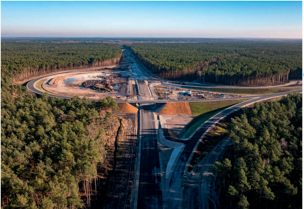
Abbildung 38 B 97/B 168, Ortsumgehung Cottbus, 2. Bauabschnitt Foto: Landesbetrieb Straßenwesen Brandenburg
