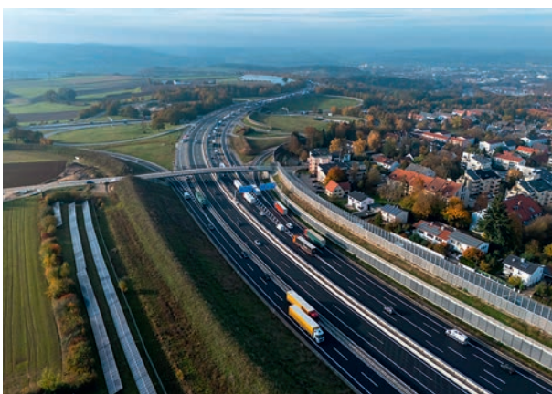
Abbildung 22 Blick auf die fertige Trasse der A 3 Richtung Westen (AK Regensburg, rechts Regensburg „Am Zieget“) Foto: Felix Bonn im Auftrag der Die Autobahn GmbH des Bundes, Niederlassung Südbayern
