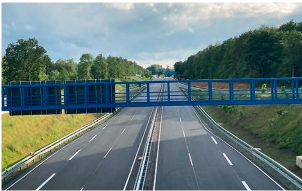
Abbildung 25 Fertiggestellte Asphaltfahrbahn aus offenporigem Asphalt A 448 Foto: Die Autobahn GmbH des Bundes, Niederlassung Westfalen
