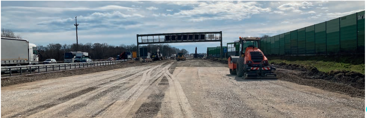
Abbildung 30 Baustelle auf der A 99
