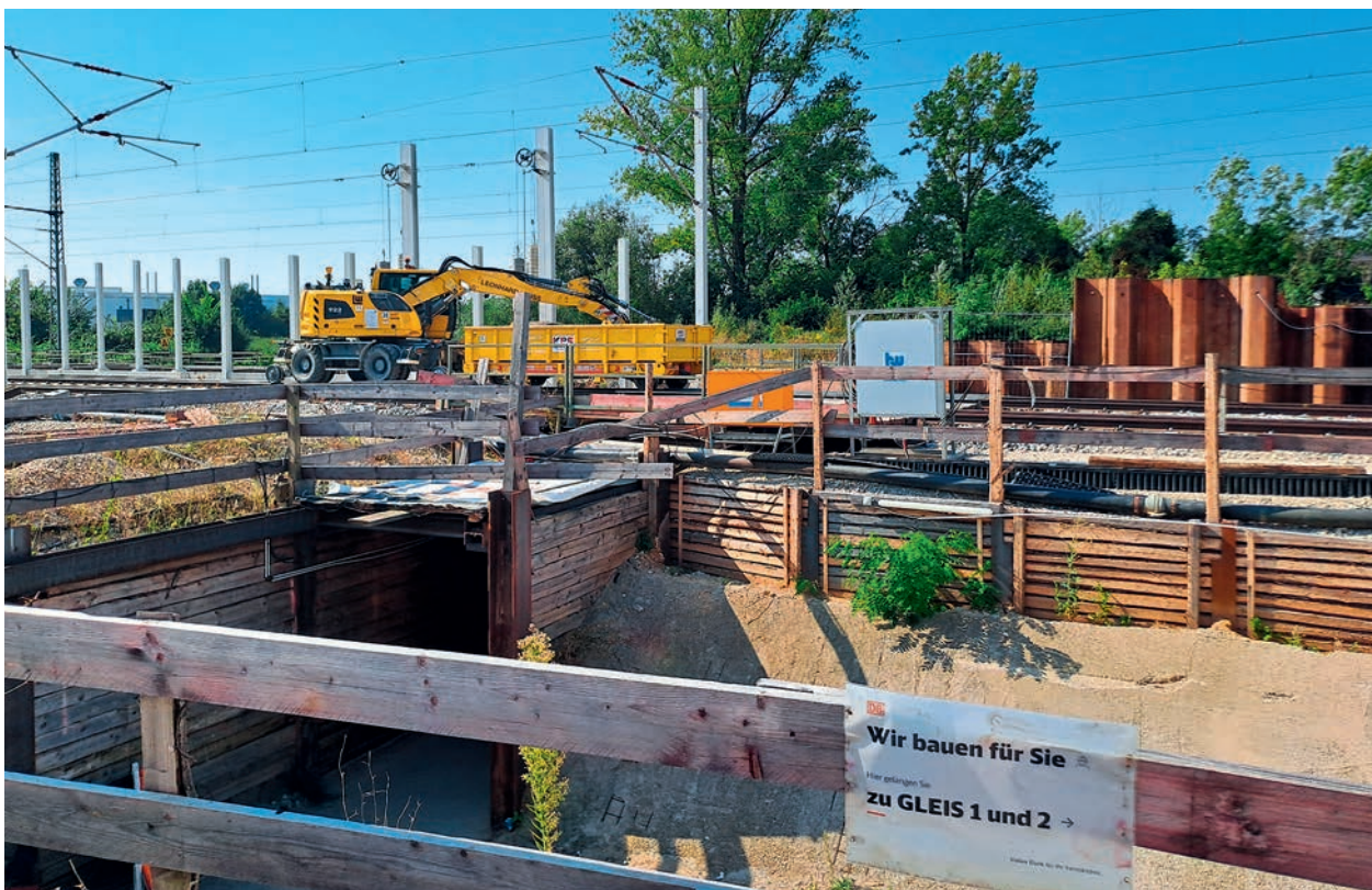
Abbildung 3 Gleisbauarbeiten am Haltepunkt Buttenheim Foto: Rebecca Zinkl
