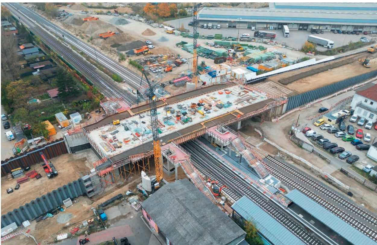
Abbildung 6 Straßenüberführung Buckower Chaussee (Projekt Dresdner Bahn) Foto: DB E&C
