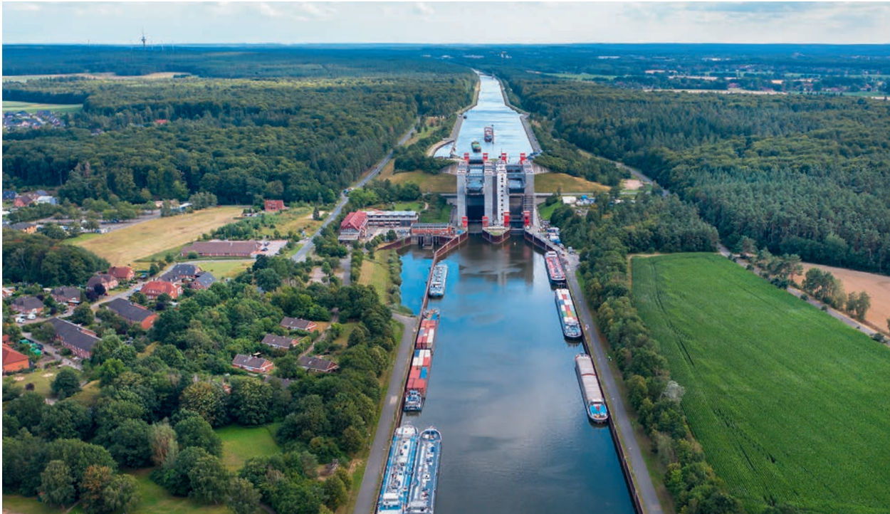
Abbildung 56 Sanierung Schiffshebewerk Lüneburg-Scharnebeck/Elbe-Seitenkanal Foto: Wasserstraßen- und Schifffahrtsverwaltung des Bundes (WSV)
