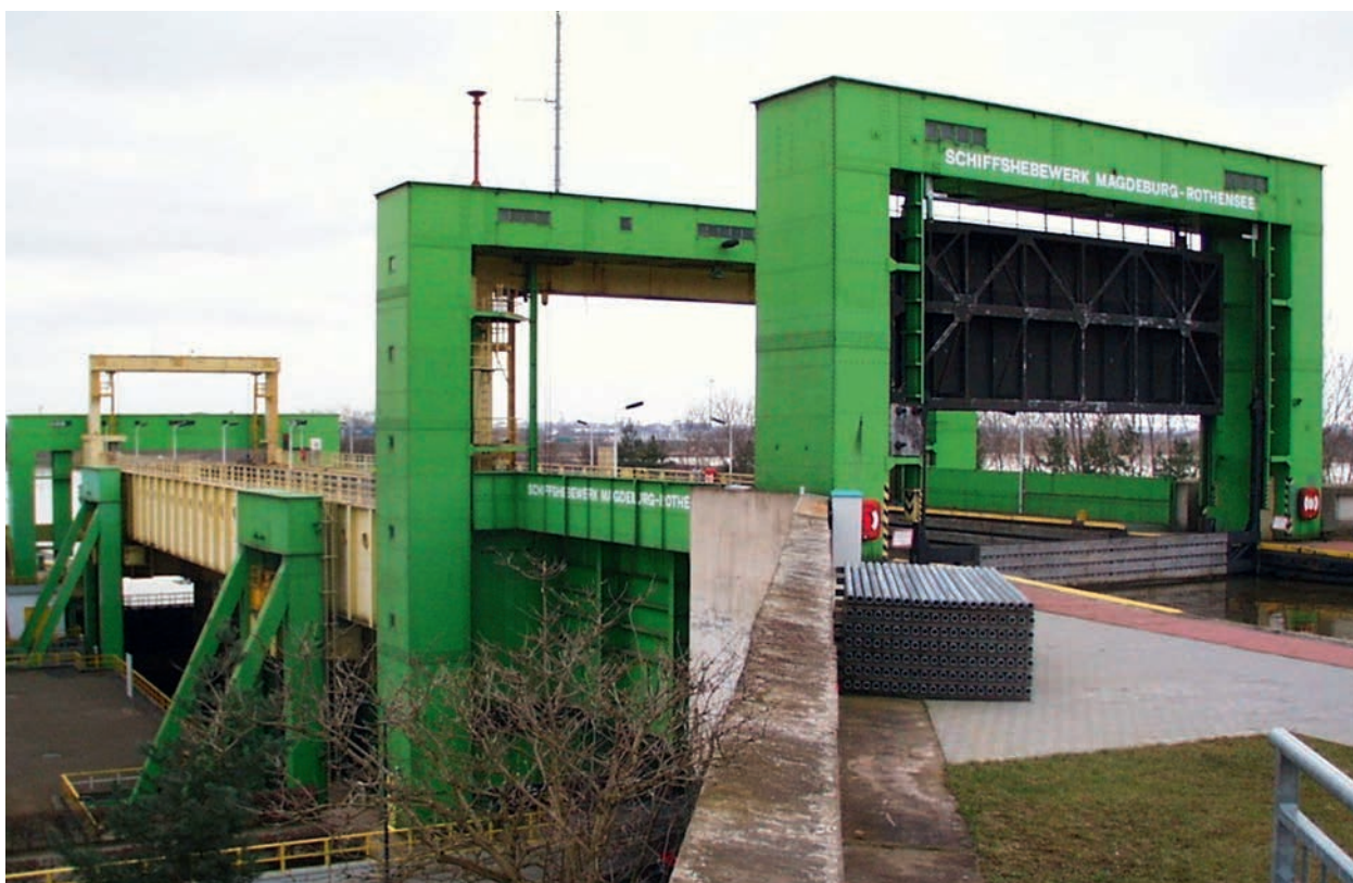
Abbildung 55 Schiffshebewerk Rothensee/Mittellandkanal Foto: WSV
