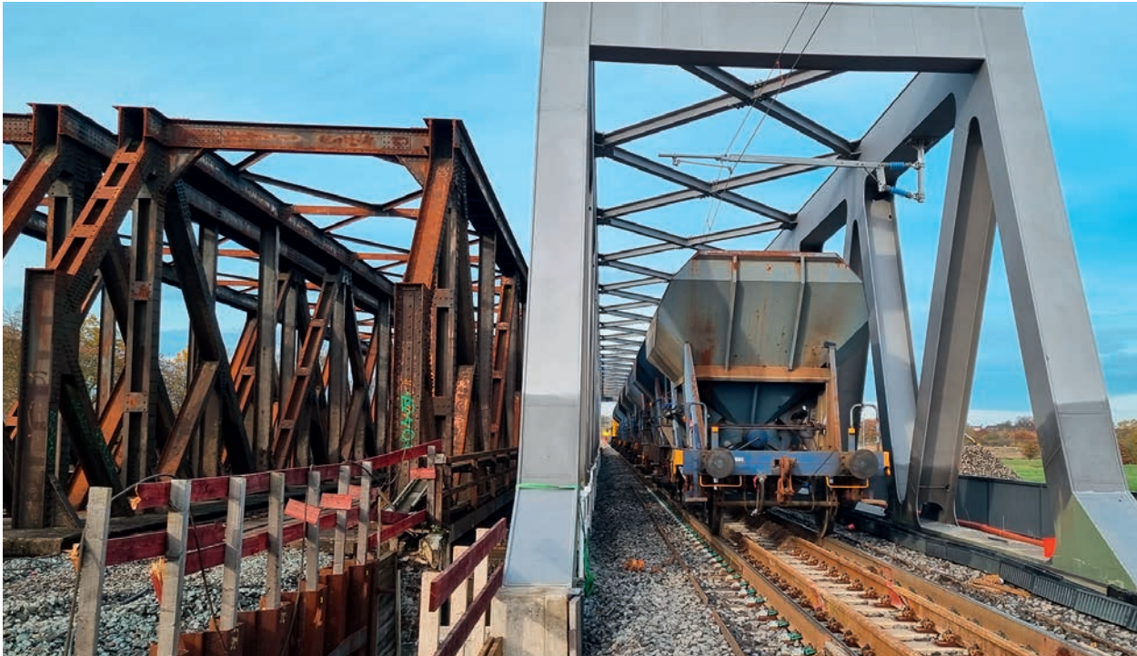
Abbildung 9 Wesel – EÜ Lippe – Neues Bauwerk und Bestandsbauwerke Foto: Deutsche Bahn AG
