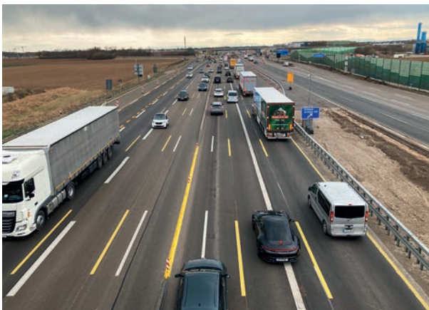
Abbildung 31 Baustellenverkehrsführung auf der A 99
