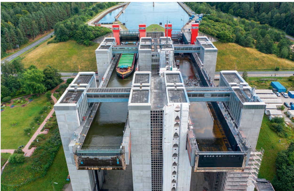
Abbildung 57 Sanierung Schiffshebewerk Lüneburg-Scharnebeck/Elbe-Seitenkanal Foto: WSV
