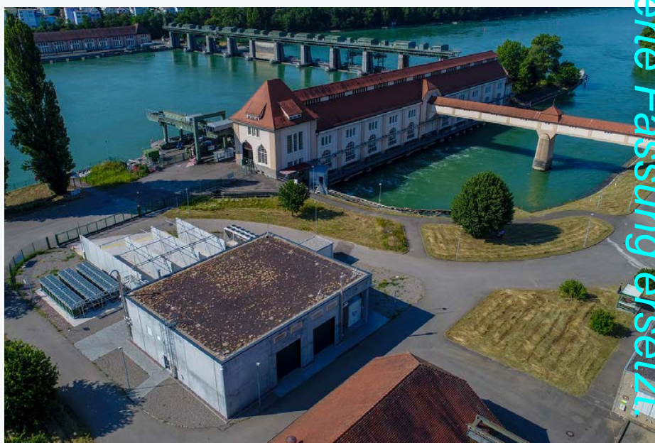
Im Reallabor H2-Wyhlen erproben Expertinnen und Experten, wie grüner Wasserstoff aus erneuerbaren Energien effizient erzeugt, gespeichert und für die Energiewende nutzbar gemacht werden kann.
